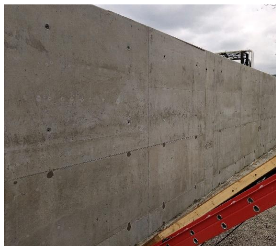
After concrete pour for derailment wall.
